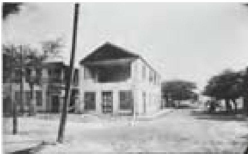
شکل ۱-۱ ساختمان با سقف شیروانی ساخته شده از آجر در گوشه خیابان های Queen و Mazyck. زلزله: چارلستون، SC ۳۱ آگوست ۱۸۸۶
