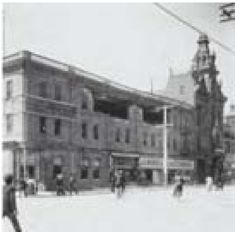
شکل ۷-۱ گسیختگی دیوار در ساختمان Oakland Cyclery and J.A. Munro & Co. زلزله: سان فرانسیسکو، CA ۱۸ آوریل ۱۹۰۶.
