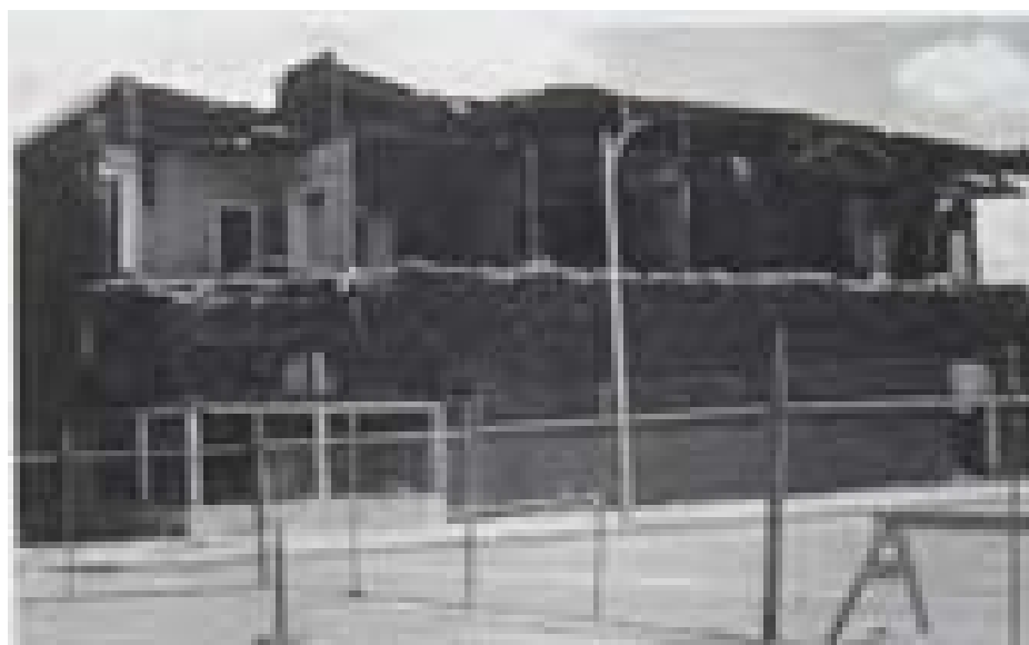
شکل ۱۰-۱ دیوار گسیخته بیرونی طبقه دوم یک ساختمان اداری. زلزله: کولینگا، CA ۲ می ۱۹۸۳
