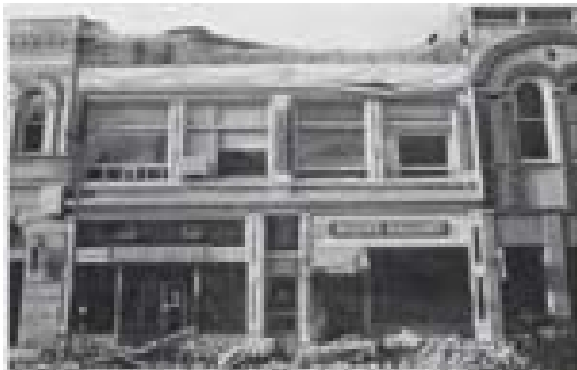
شکل ۱-۲ گسیختگی جان پناه. زلزله: لوما پریتا، CA ۱۷ اکتبر ۱۹۸۹
