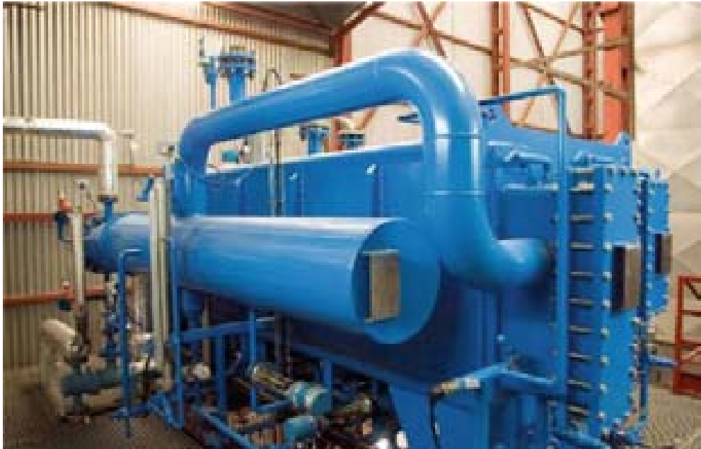
شکل 1-10 پمپ حرارتی جذبی دو اثره واقع در پلنفرم خورشیدی آلمریا
