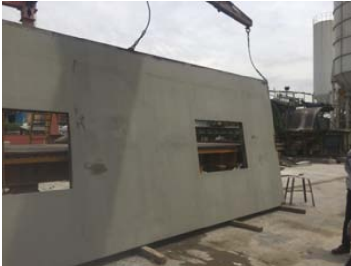
شکل 1-3 پیوستگی دیوارهای پیش ساخته سه بعدی از پایین تراز تا بالاترین تراز
