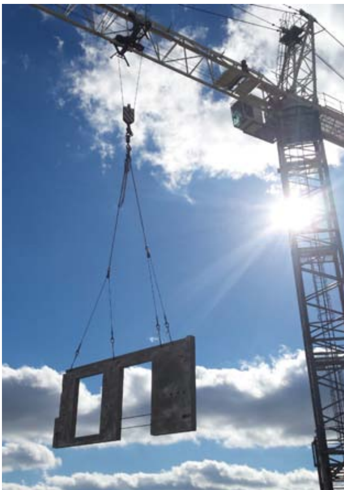
شکل 1-6 حمل و نصب سیستم دیوار پیش ساخته سه بعدی [3]
