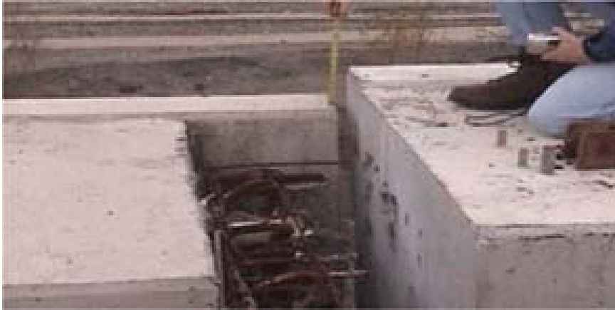
شکل ۱-۱: تغییر مکان قائم پل Bolu در ترکیه سال ۱۹۹۹
