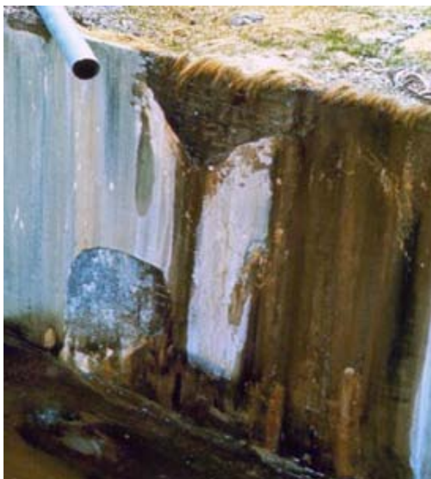
شکل ۲. تغییر محل خروجی آب می‌توانست به میزان قابل‌ملاحظه‌ای از وسعت آسیب بکاهد.
