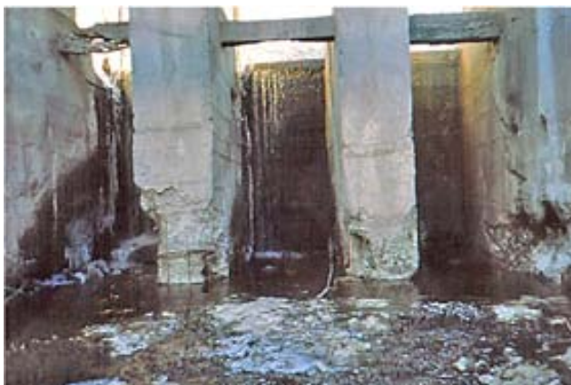
شکل ۱. آسیب‌دیدگی ناشی از یخ‌زدگی-ذوب‌شدن. تدوین یک برنامه‌ی نگهداری دقیق می‌توانست از این وضعیت جلوگیری کند.
