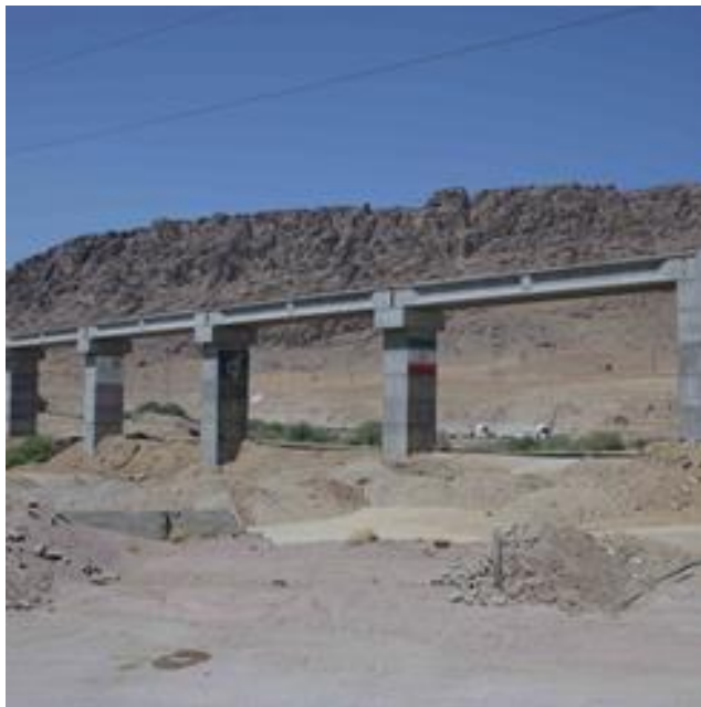
نمایی از عرشه و پایه های میانی پل واقع در مسیر راه آهن دورود-خرم آباد
