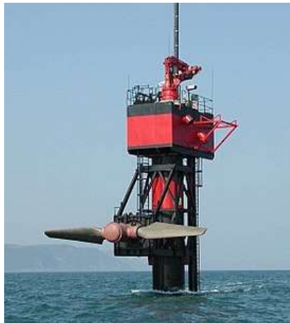
شکل ۹: مبدل انرژی کشند سی‌گن با توربین ۳۰۰ کیلووات
