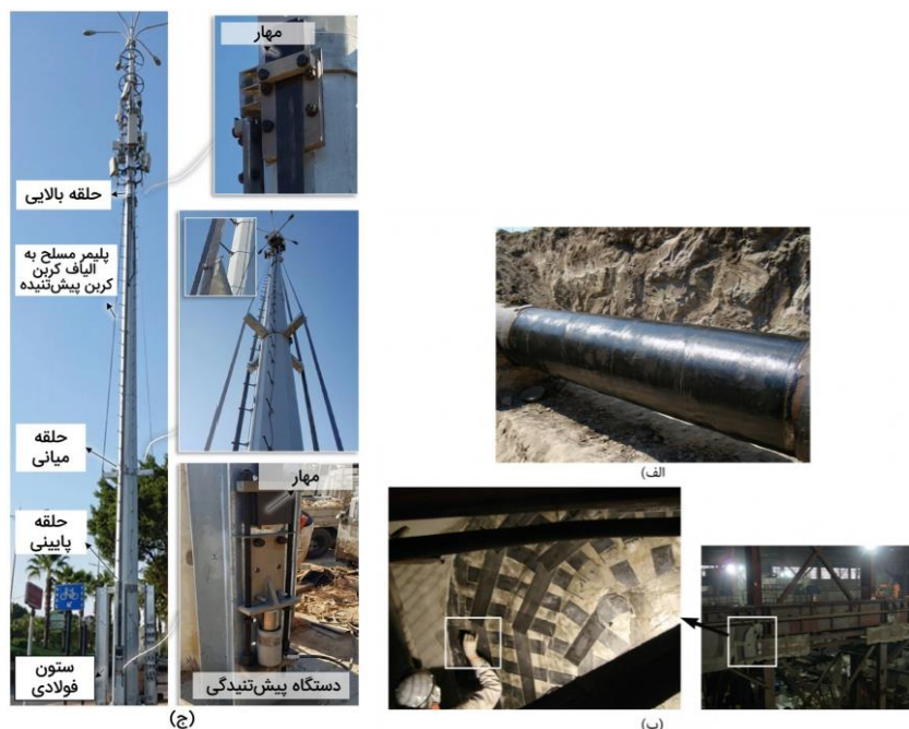
شکل ۱.۲ تعمیر خطوط لوله نفت، تیرهای جرثقیل و برج‌های مرتفع در چین با CFRP. (الف)
